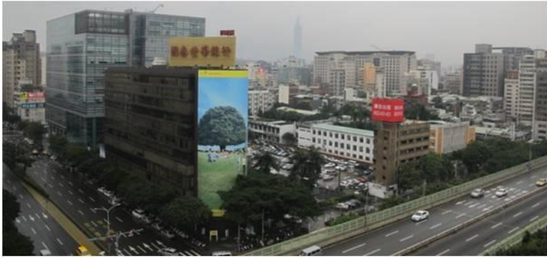
建物結構老舊、內部設施不足，不符現代化商業機能。
