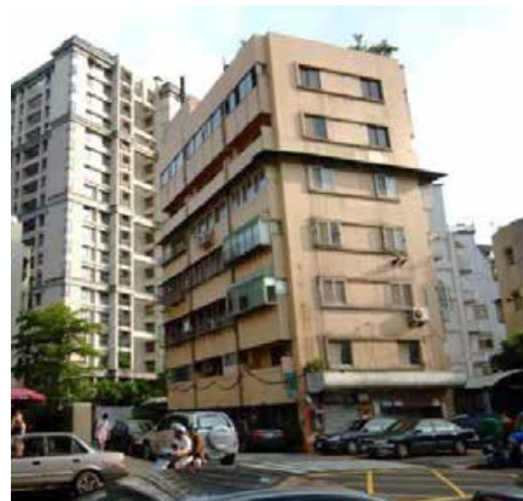
芝山鑽石大樓是本基金會近期協助的海砂屋重建案例。
