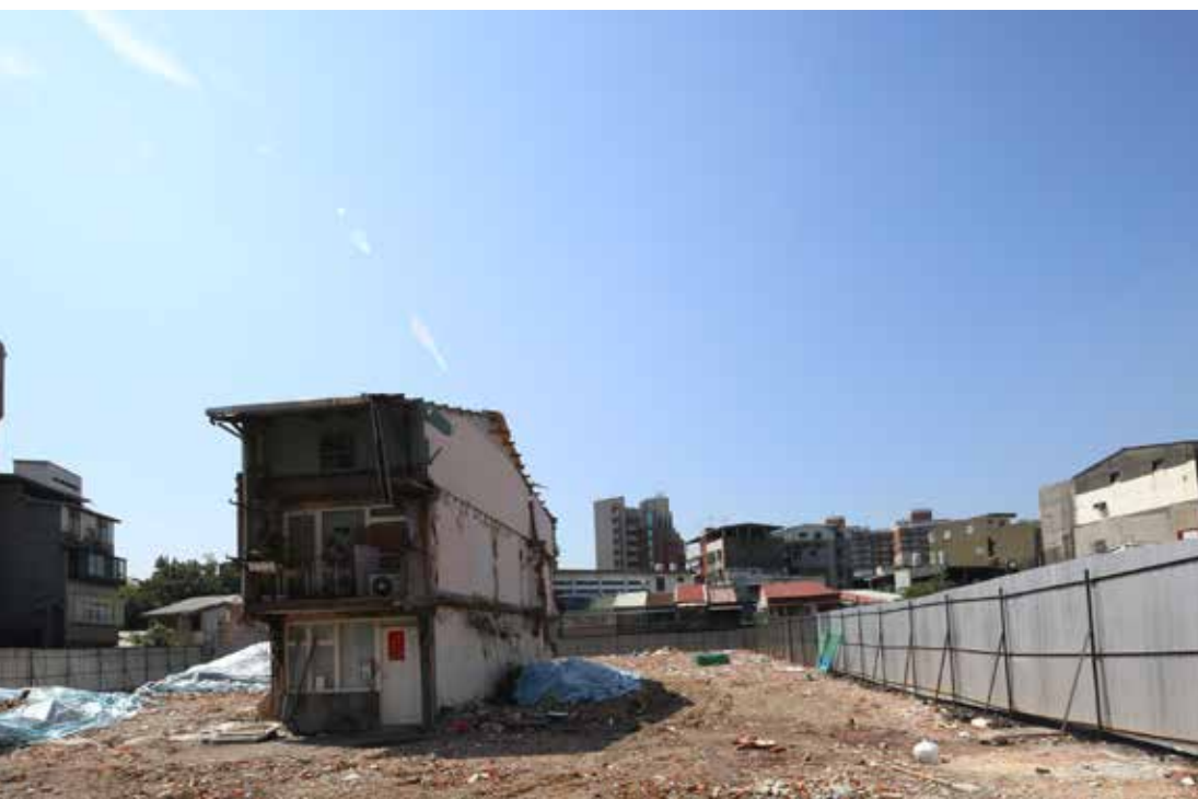
汀州路案拆除過程發生「龍腦事件」。
