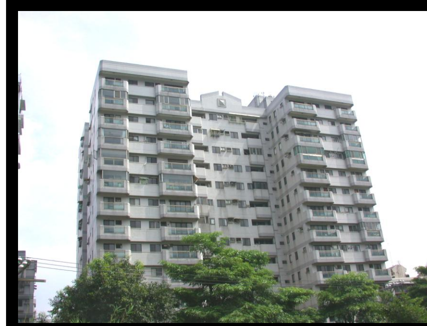
■ 國泰攬翠天廈九二一震災危樓全棟外觀（南面）
