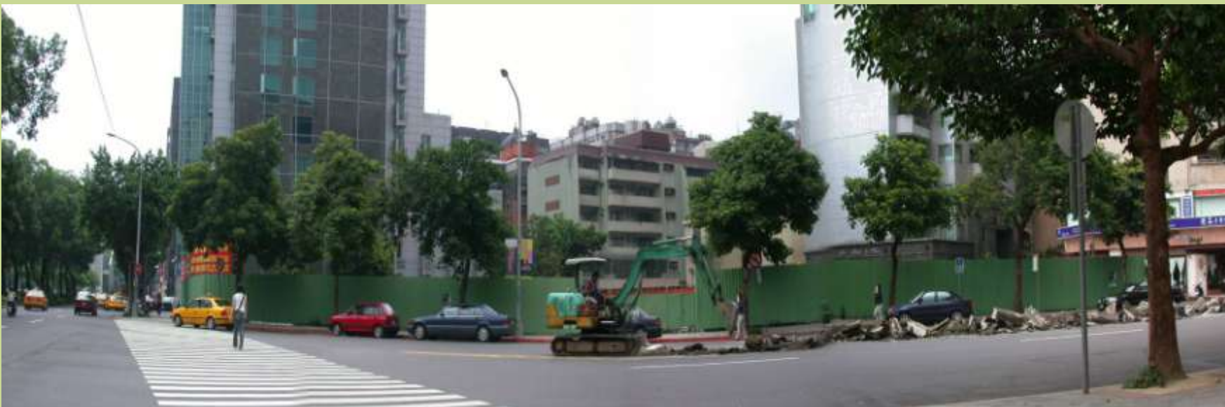
勝利大廈拆除後基地現狀
