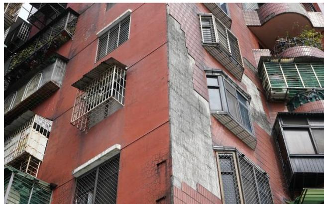
因為 0403 強震導致房屋結構受損(左)及社區外牆磁磚掉落(右)(資料照片)
