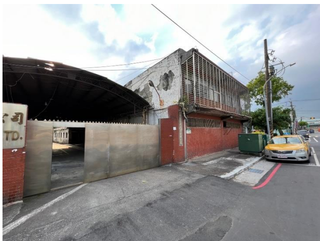
更新前建物現況
