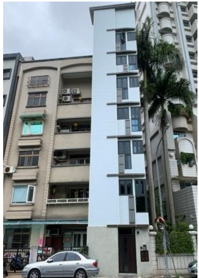
文山區木新路二段水岸精華公寓大廈更新前後
