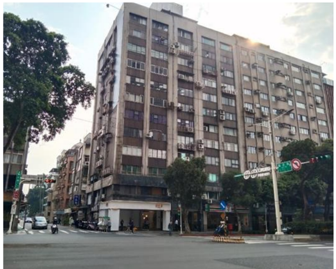
更新前範圍內南側(左)及北側(右)建築物現況
