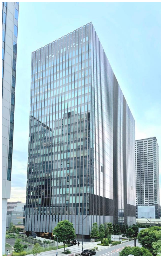
完工後建築立面(本基金會攝)
