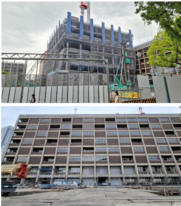
商辦大樓新建(上)與舊市廳舍整建(下)施工現況(本基金會攝)
