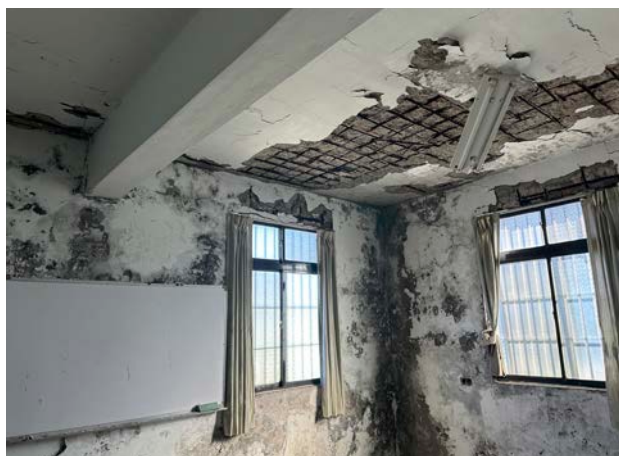
更新前建築物內部現況圖 (資料來源:禾蓮開發股份有限公司)
