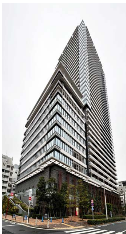
完工後建物現況圖 (林宜樺攝)
