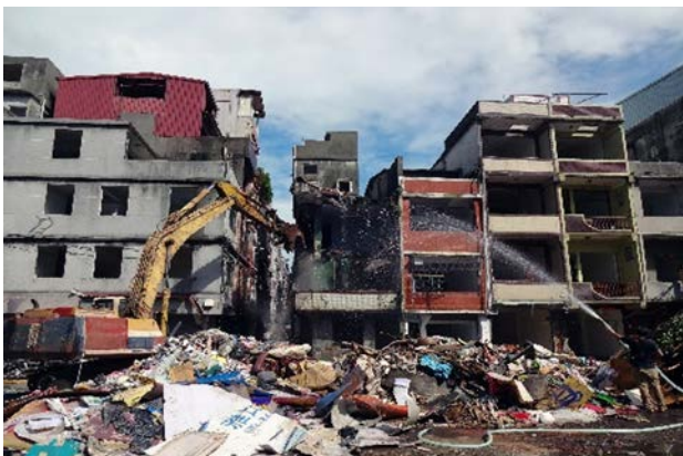
拆除老舊房屋 (資料來源:新北市政府都市更新處)
