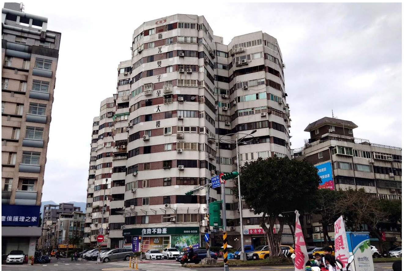
雙子星大樓社區現況外觀照片（資料來源：臺北市都市更新處）
