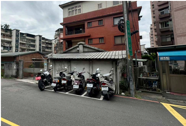
秀朗路三段側更新前水溝現況照片 (本基金會攝)
