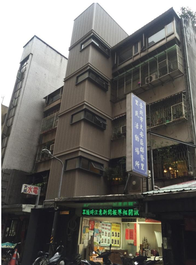
大安區和平群賢華廈增設電梯後現況
