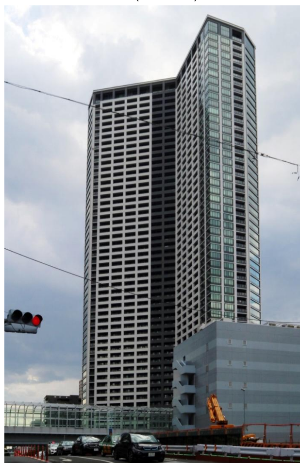
B-1 街區棟(勝鬨 TOWER)建築採 3 翼展開型式，樓高 53 層 (林宜樺 攝)
