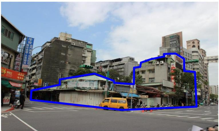
更新前多為 4 層樓鋼筋混凝土造建物及磚造 2 層樓建物
