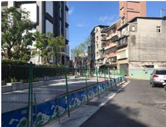
更新後協助開計畫道路更新前(左)、更新後(右)
