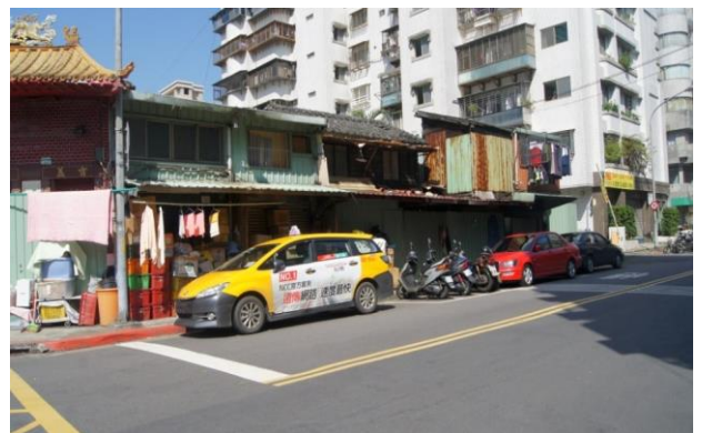
更新前建物現況多違章建築且傾頹朽壞
