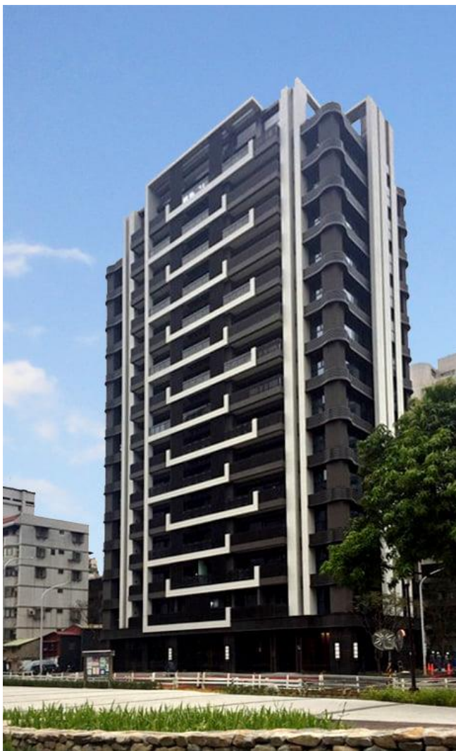
更新後建築現況
