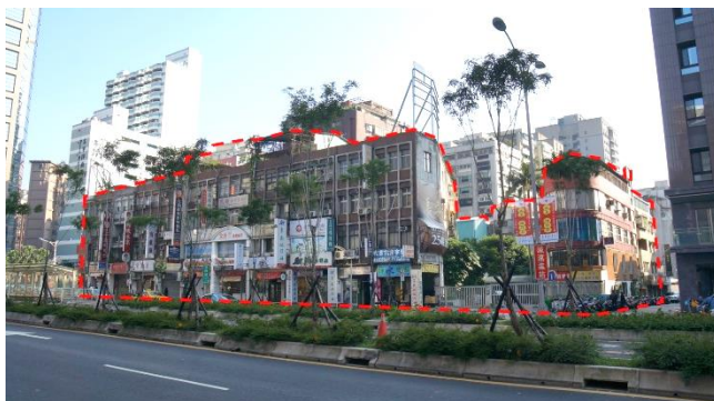
更新前建物現況
