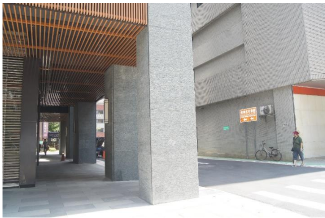
信義路一側更新後設置騎樓 延續沿街商業活動
