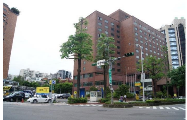
更新前建物現況
