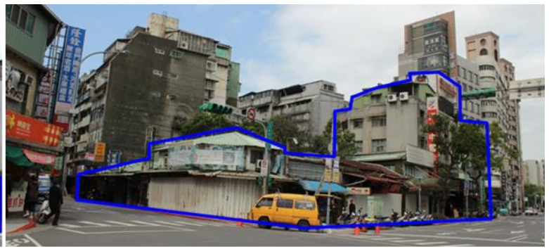
(左)建國南路一段側及(右)濟南路三段側更新前現況
