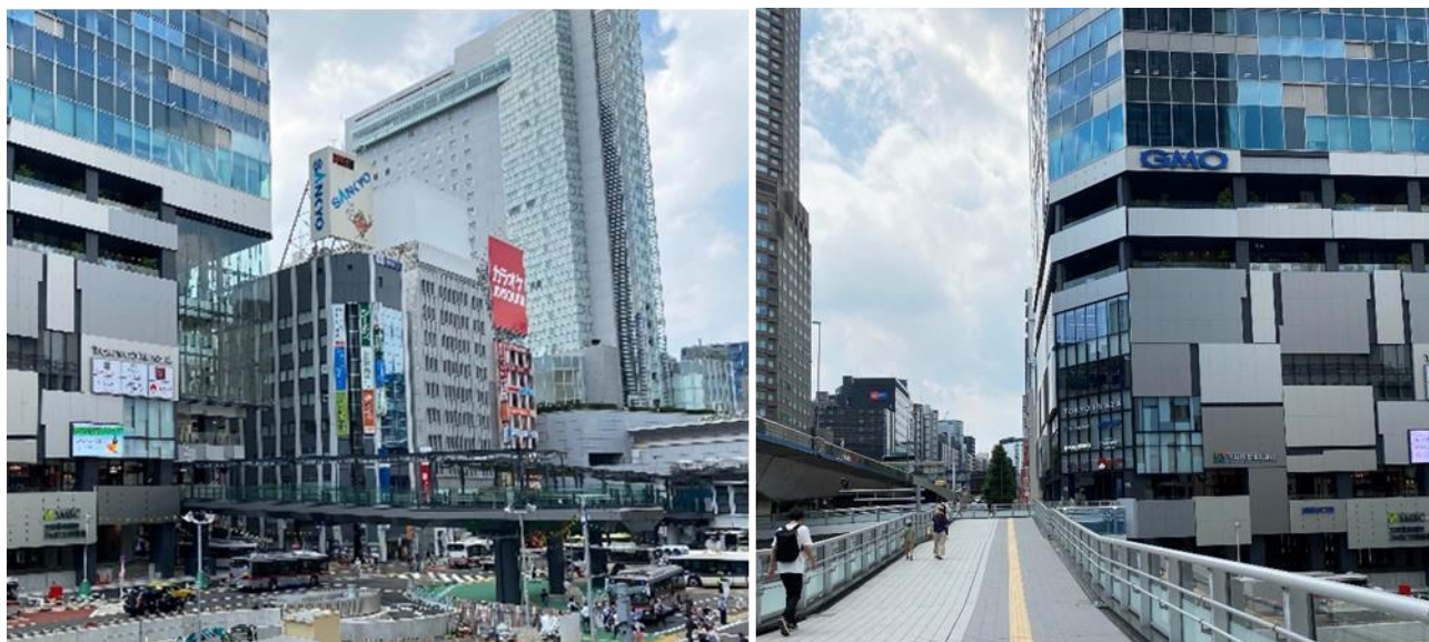
基地內透過設置高架的連絡人工地盤及空廊串聯相鄰街廓(林宜樺攝)
