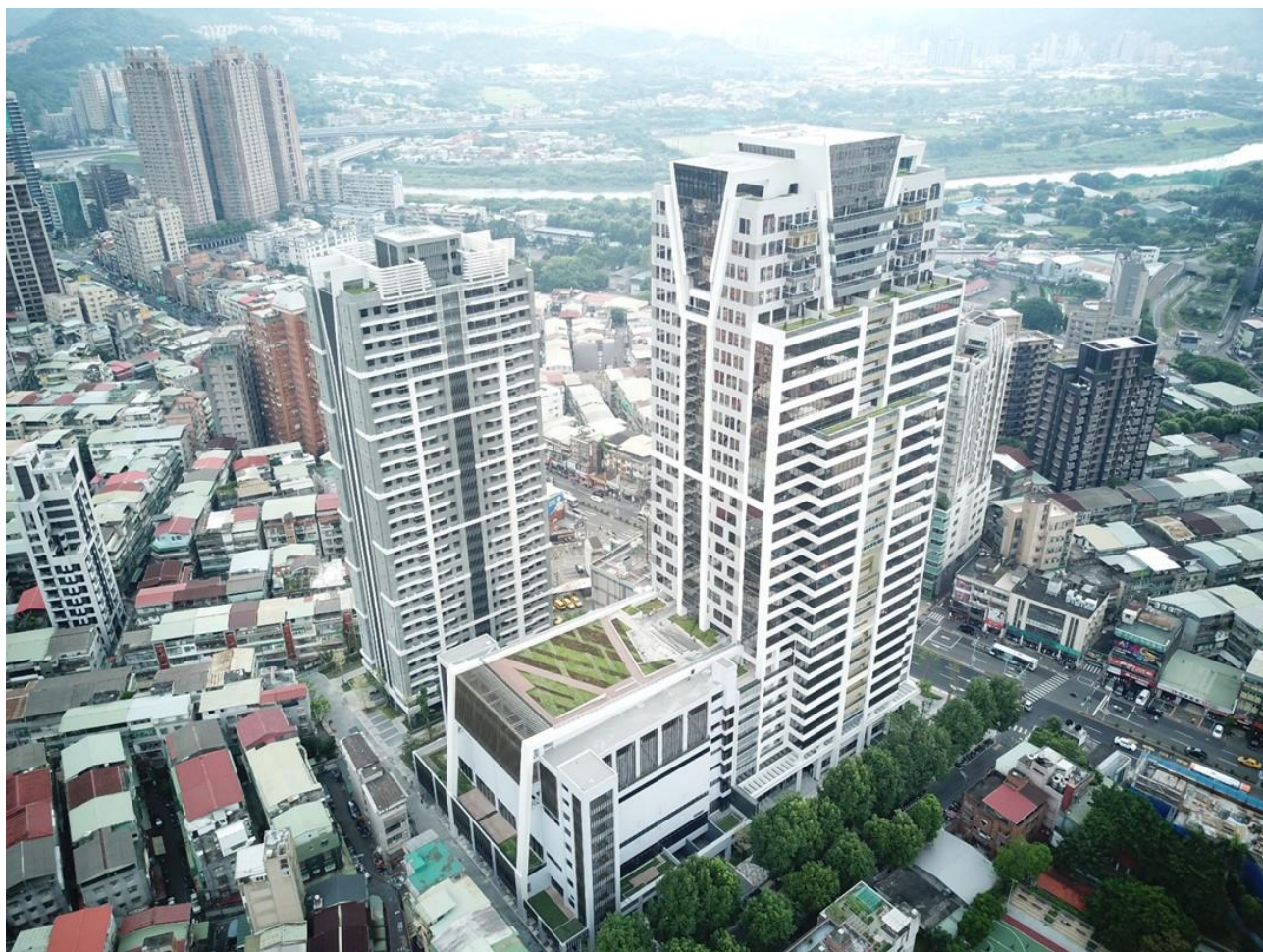
更新後建物現況(圖片來源：冠德建設提供)
