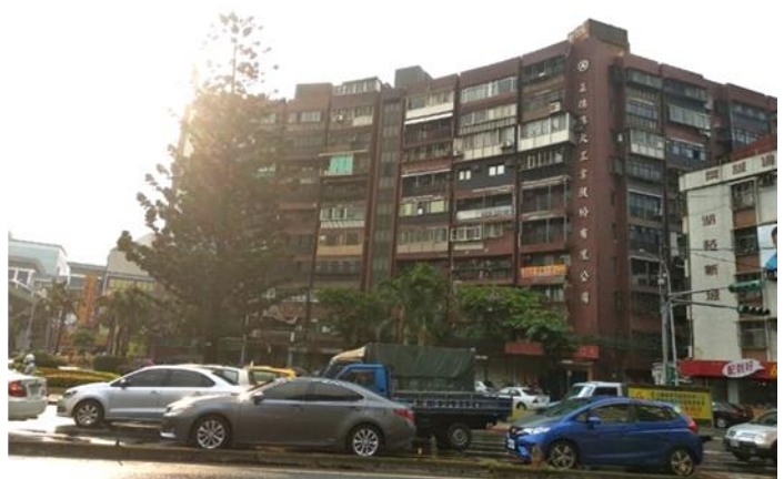
大樓外觀破損嚴重，佈滿裂痕
