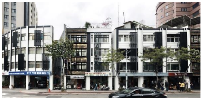
府中郵局周邊建築物施工前後
