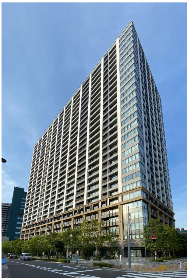
更新後建物現況(林宜樺攝)
