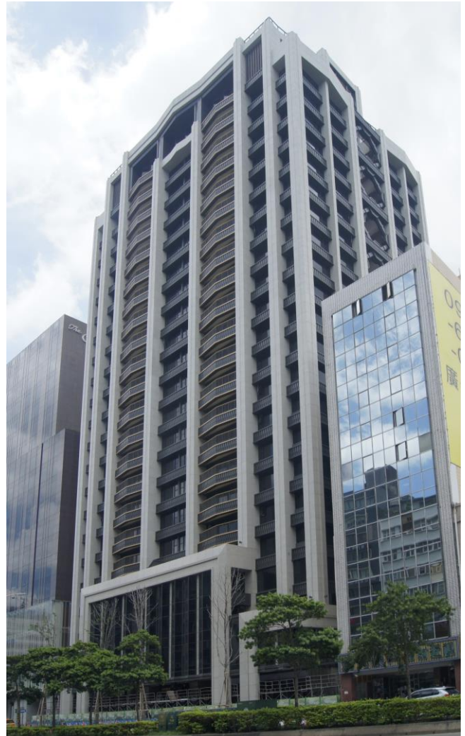
更新後建物現況
