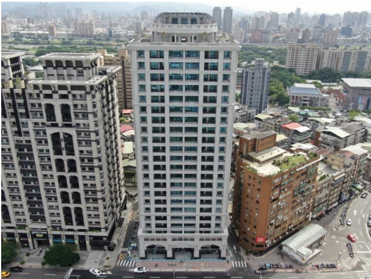
更新後建物現況
