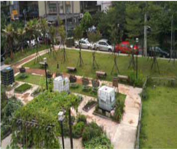
「臺北好好看計畫」- 拆除老舊建物，施作景觀綠化工程
