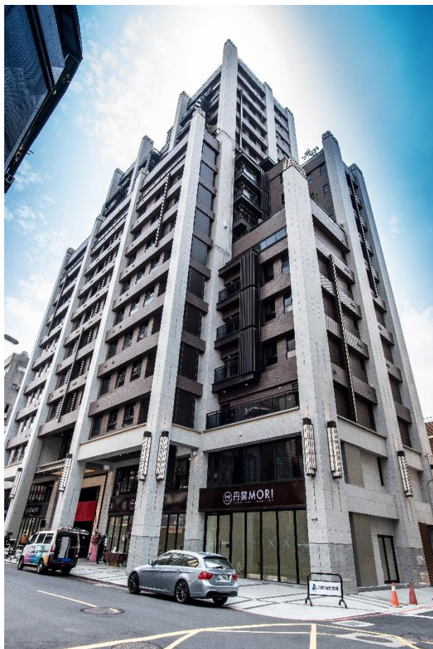
丹棠 MORI 完工後建築外觀現況
