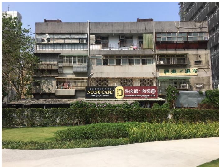
更新前建物現況
