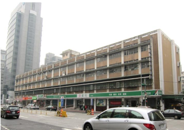
更新前建物現況
