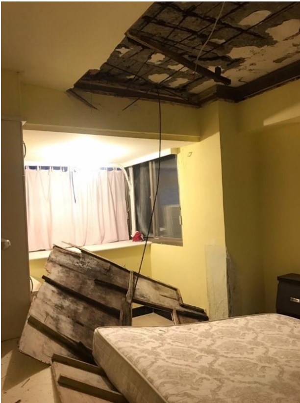
更新前室內現況
