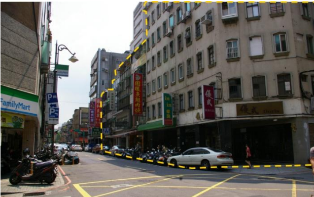
天津街現況 3、4 樓公寓及變更單元範圍後納入之 7 樓華廈
