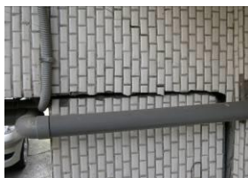
外牆柱斷裂
